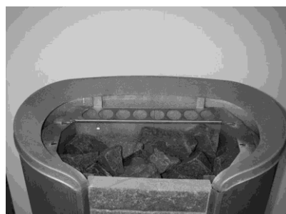
Imagen 10 Montaje de esteatitas de la calentador
